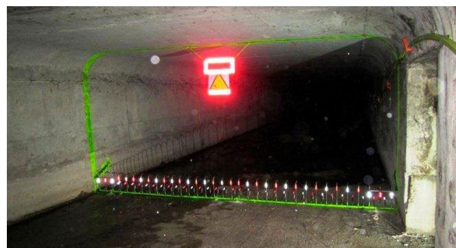
Peines de retención alcantarillado Barcelona.
