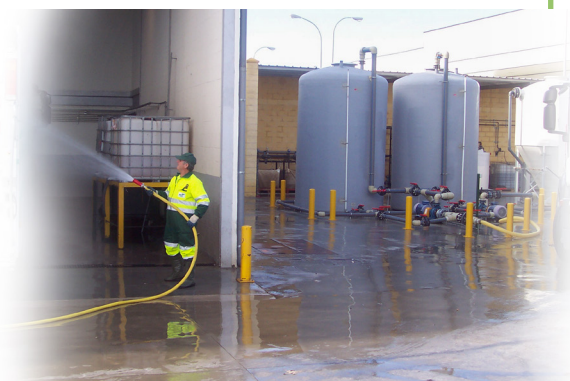
Reciclado de agua de las duchas para su uso en el lavadero.
