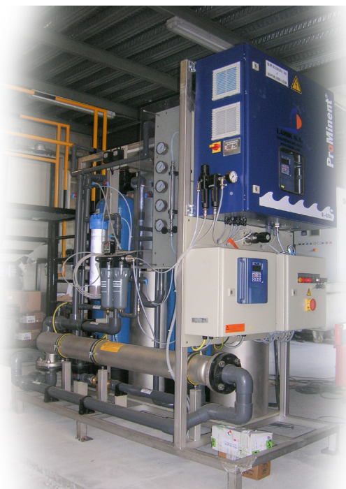
Reciclado de agua de las duchas para su uso en el lavadero.
