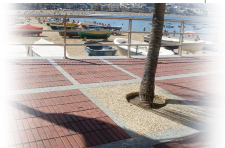
Instalación de pavimento drenante en alcorques.
