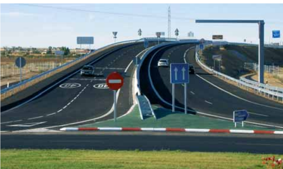
Autovía del Duero dual carriageway Toro-Zamora section
