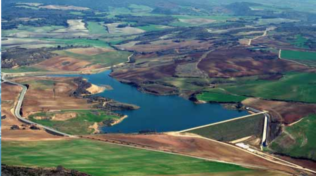
Treviño Dam. Burgos
