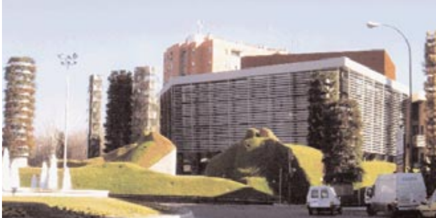
Piscina cubierta Los Rosales. Móstoles. Madrid
