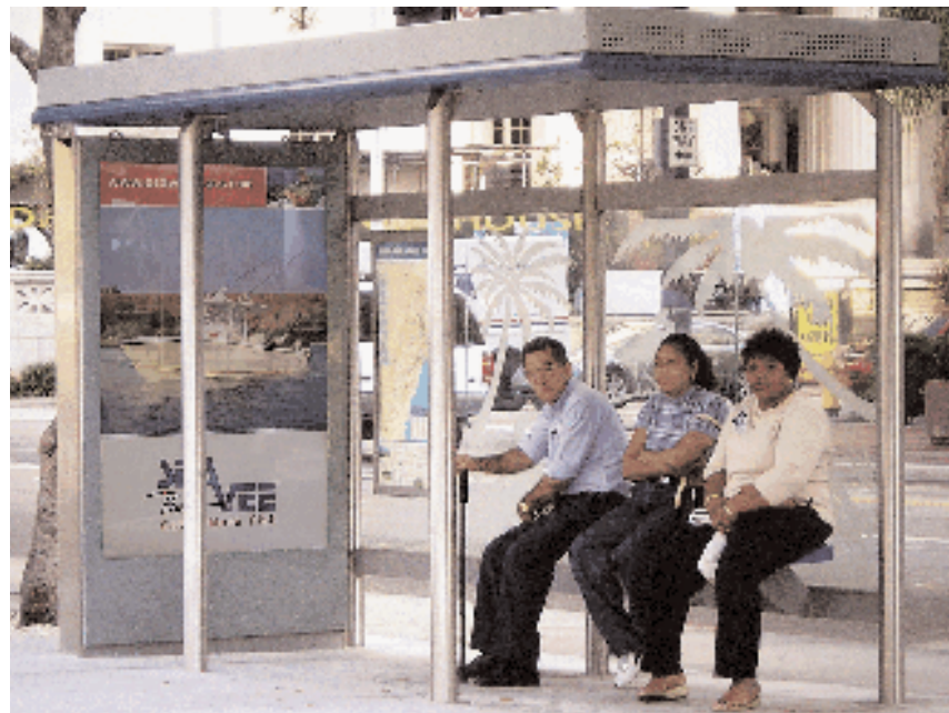
Marquesina solar en Miami. EE.UU.
