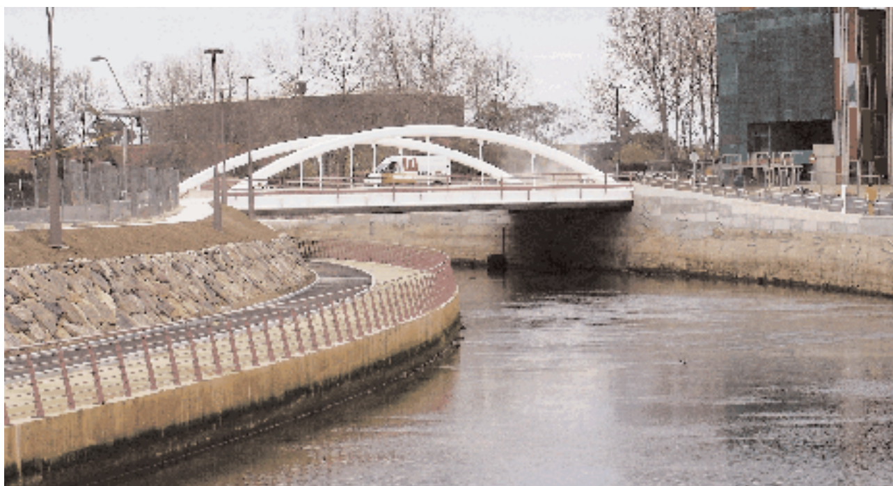
Acondicionamiento del río Piles. Gijón. Asturias
