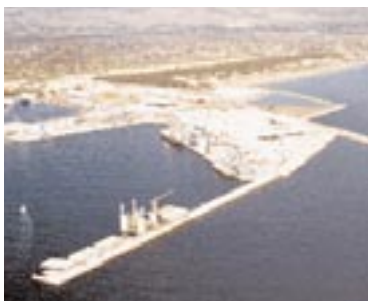
Remodelación del puerto de Castellón
