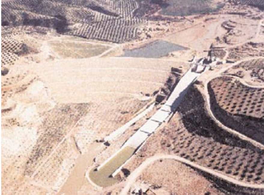
Presa de Vadomójón. Córdoba
