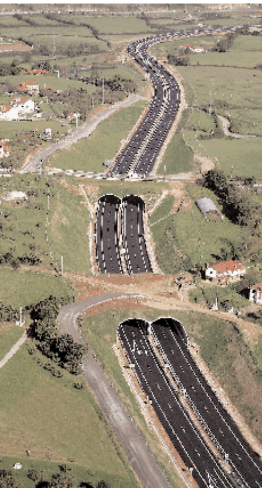
Autovía Minera. Asturias
